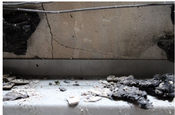
(b) Zweite Brandsperre auf 4,55 m, kein Ablösen der Brandsperre von Prüfstandwand.
